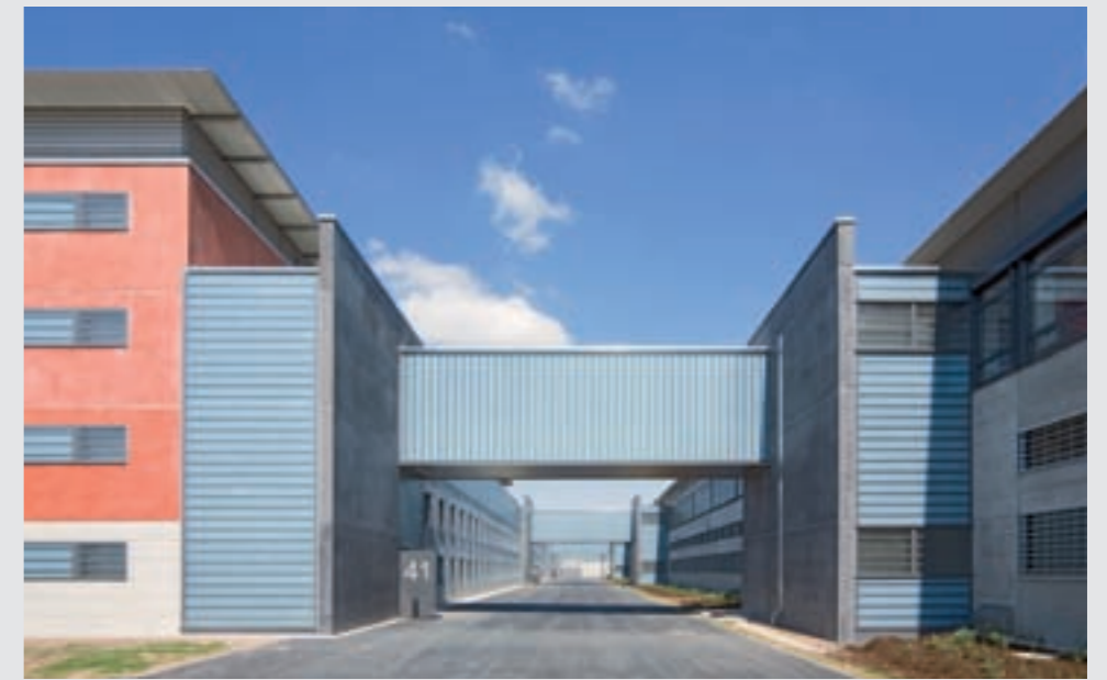
Blick in die Magistrale mit den Verbindungsbrücken
